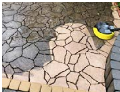
ČISTENIE POVRCHU A IMPREGNÁCIA
