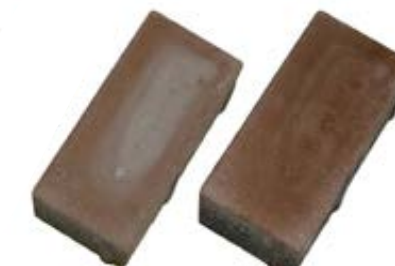
Povrch dlažby s vápenným výkvetom pred čistením a po vyčistení Rebanitem S
