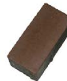
Povrch dlažby bez vápenného výkvetu
