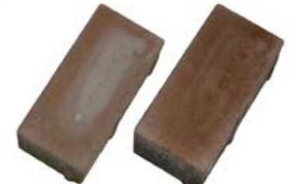
Povrch dlažby s vápenným výkvetom pred čistením a po vyčistení Rebanitem S
